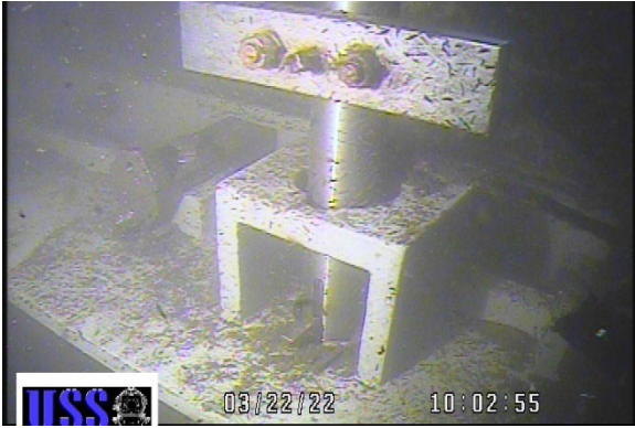
Stem & thrust nut
